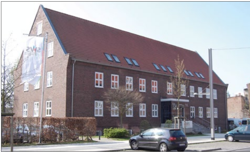
Firmensitz der SWS Netze GmbH am Frankendamm in Stralsund
